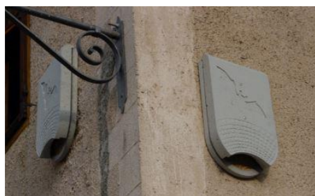
Gîtes à chauves-souris en façade d'un bâtiment
