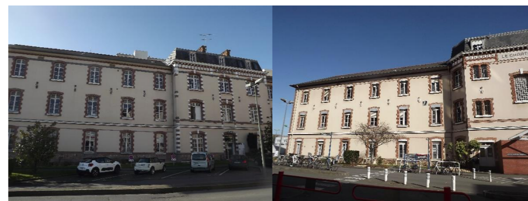
Bâtiments « Ballé » et « Le Chartier » accueillant la nidification du Martinet noir
