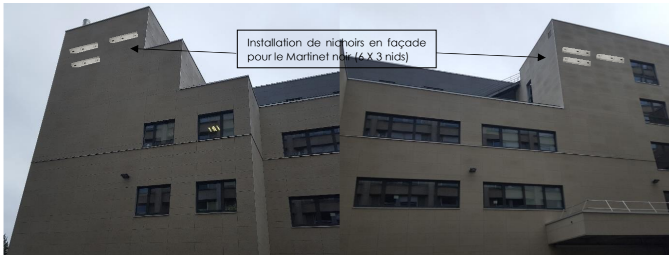
Façade NORD du bâtiment BMT-HC
